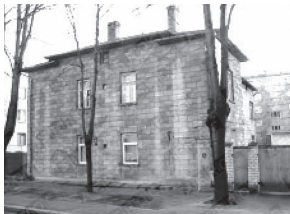
Рис. 1. Здание из ячеистого бетона автоклавного твердения без наружной отделки (постройка 1939 г.), г. Рига, ул. Эльвирас, 15
