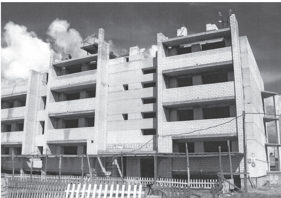
Рис. 9. Панель на этаж 40-квартирного дома в г. Сморгони
