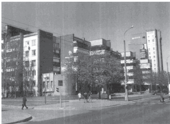
Рис. 4. Жилые дома с несущими стенами из кирпича и наружными из газосиликатных панелей двухрядной разрезки
