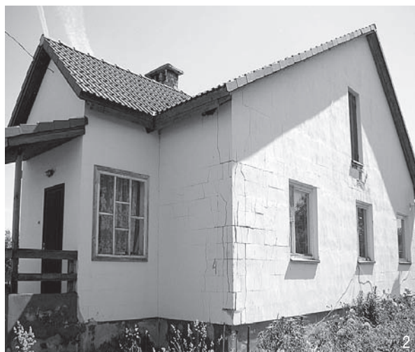
Рис. 2. Фрагменты разрушений стеновых ограждающих конструкций: 1, 2 – 8-я городская гинекологическая больница, г. Минск; 3, 4 – жилые дома, Минский р-н, г. Логойск; 5, 6 – ясли-сад № 2, Молодечненский р-н, д. Чисть
