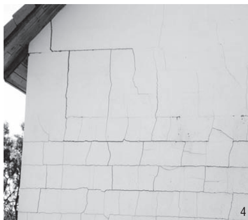
Рис. 2. Фрагменты разрушений стеновых ограждающих конструкций: 1, 2 – 8-я городская гинекологическая больница, г. Минск; 3, 4 – жилые дома, Минский р-н, г. Логойск; 5, 6 – ясли-сад № 2, Молодечненский р-н, д. Чисть
