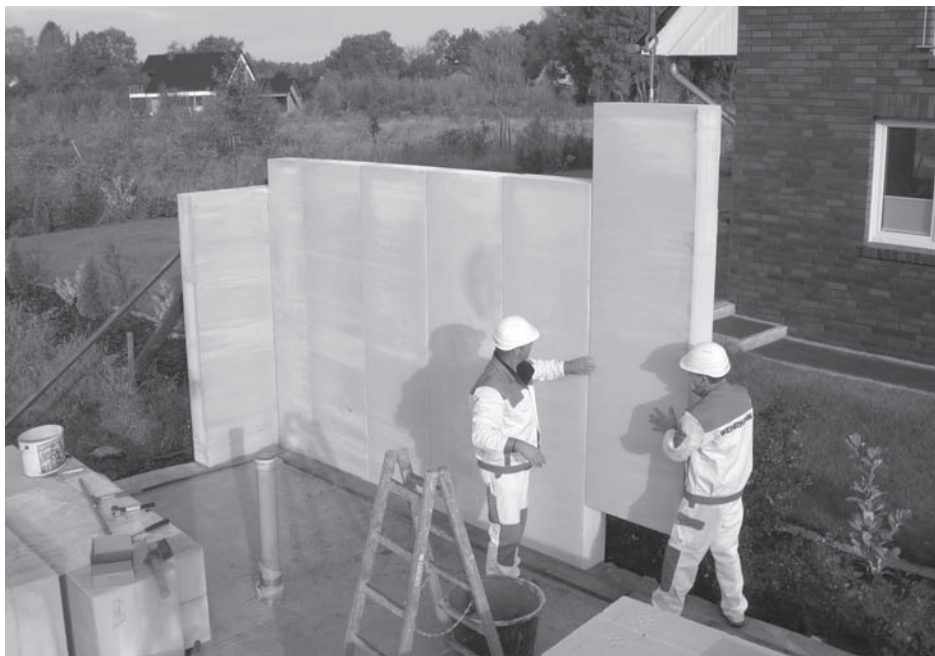
Установка вертикальных стеновых плит – строим дом быстро и эффективно!
