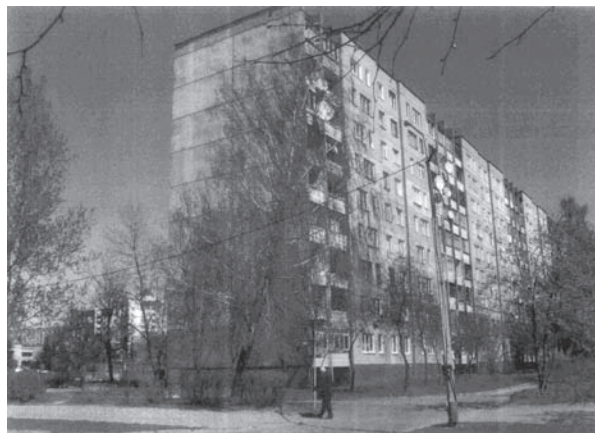
Рис. 3. Экспериментальный дом в г. Гродно. Внутренний осто́в – из железобетонных панелей, наружные стены – из газосиликатных панелей на этаж
